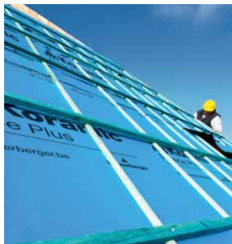
Door zijn speciale coating is Fleece Plus beter bestand tegen temperatuurschommelingen en uv-straling dan traditionele onderdakfolies. Bovendien is de folie capillair.
