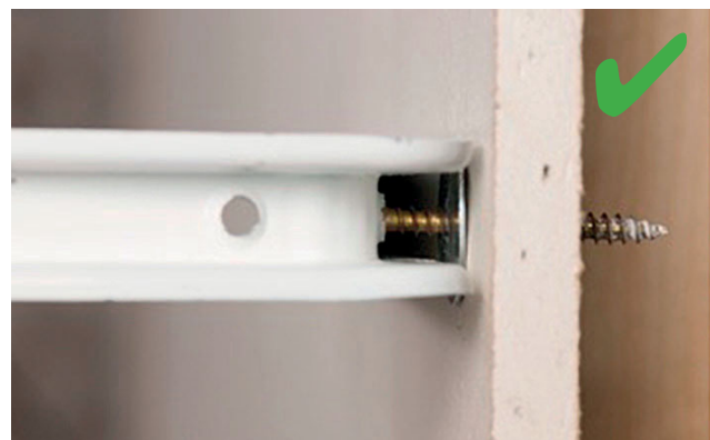
Gesimuleerd rechtstreeks contact door toevoeging van sluitring
